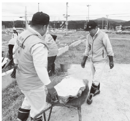
住宅の瓦礫撤去作業の様子
