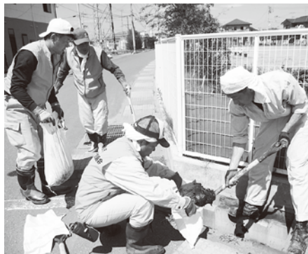
側溝の泥かき作業
