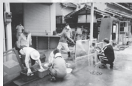
機材の洗出作業（佐用町）
