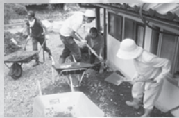
土砂の撤去作業（朝来市）
